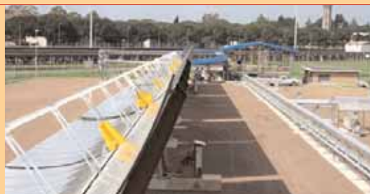
The Prova Collettori Solari facility at Italy's ENEA Casaccia Research Centre.
